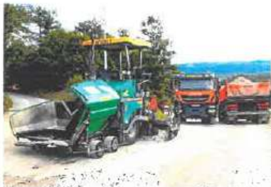
U tijeku radovi na lokalnoj cesti prema Škuljarima
